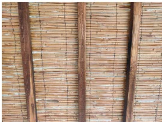
COPERTURA REALIZZATA CON S'INCANNITZAU
