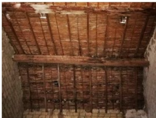
COPERTURA REALIZZATA CON S'INCANNITZAU
